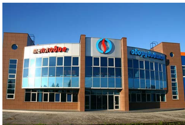
Завод «Тепловое оборудование»
